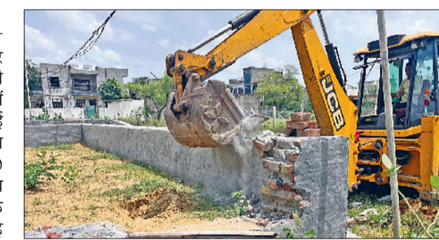
नारनौल। अवैध निर्माण हटाती जेसीबी मशीन।
